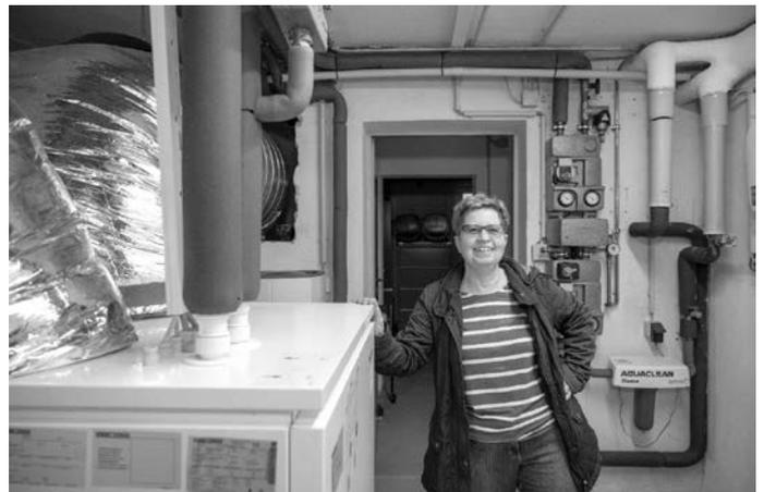
Das Einfamilienhaus in Heidelberg wird vollständig durch eine komplett im Keller untergebrachte Luft-Wasser-Wärmepumpe beheizt. Wärmepumpe und der hydraulische Abgleich wurden durch die BAFA gefördert. (Foto: Gülay Keskin)
