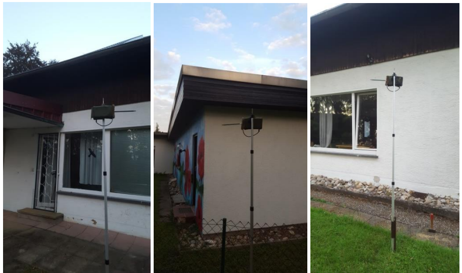
Foto 19: Potentiell für die Zwergfledermaus geeignete Spaltenquartiere an dem im Untersuchungsgebiet befindlichem Gebäude mit in unmittelbarer Nähe aufgestellten akustischen Aufnahmesysteme zur Kontrolle ausfliegender Tiere.
