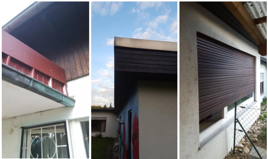
Foto 18: Potentiell für die Zwergfledermaus geeignetes Spaltenquartiere (links: Öffnung in der Dachverkleidung; rechts: Rollladenkästen) an den im Untersuchungsgebiet befindlichem Gebäude.
