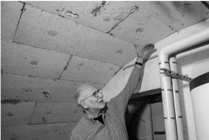
Architekt und Energieberater Bernd Nowoczyn hat sein Haus – Alt- und Neubau – in einer „Gebäudehülle“ energetisch umfassend modernisiert, inklusive Gewölbekeller mit den 10 cm starken Mineralfaserplatten (Foto: Gülay Keskin).
