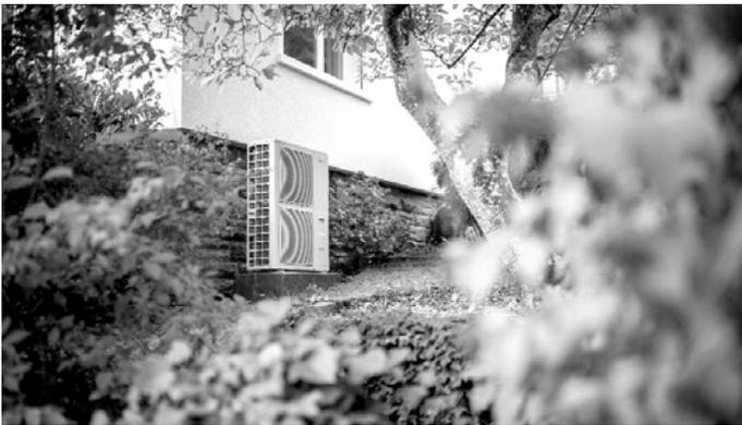
Das Hybridsystem mit Wärmepumpe und Gaskessel in diesem Einfamilienhaus in Heidelberg bringt eine Leistung um 18 kW und ist so eingestellt, dass die Heizleistung lediglich mit Gas ergänzt wird, falls nötig. (Foto: Gülay Keskin)
