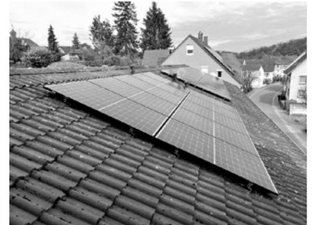
Die kommunale Liegenschaft Bahnhofstraße 5 und 7 ist nun ebenso mit einer PV-Anlage, mit einer Größe von ca. 13kWp, ausgestattet. Zusammen mit dem installierten Batteriespeicher kann ein Eigenverbrauchsanteil von 51% erreicht werden. Es wird erwartet, dass die Anlage jährlich ca. 13.000kWh Strom erzeugen wird.
