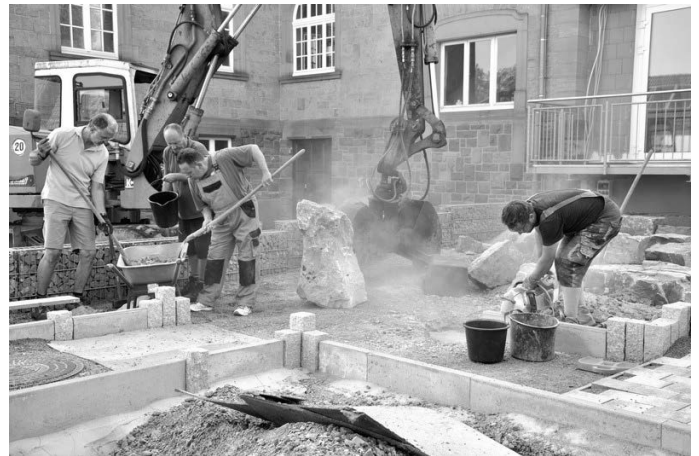
Die letzten Arbeiten an den Außenanlagen wurden vor einigen Tagen vorgenommen
